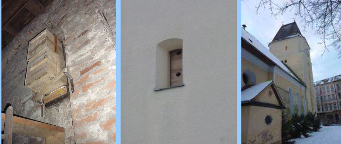
Zwei der vier neugebauten Dohlennistkästen wurden im Turm der Stephanus-Kirche in Mockau eingebaut.
