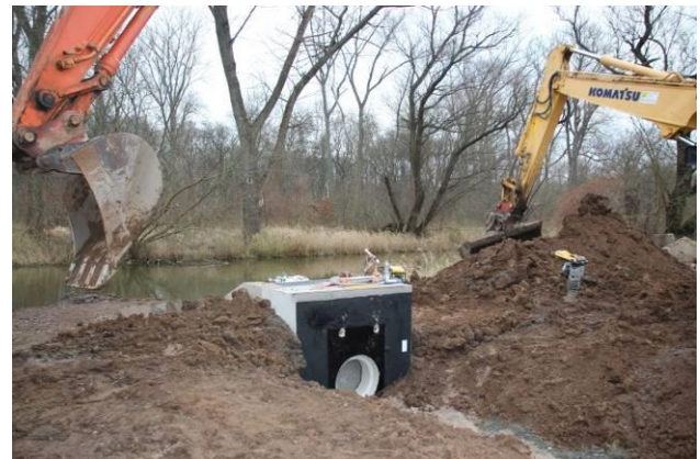
Nahaufnahme des neuen Einlassbauwerks während der Bauarbeiten am Ufer der weißen Elster. Auf dem linken Foto sieht man die Wasserseite, wo das Elsterwasser hineinfließen wird, auf dem rechten die Landseite. Hier wurde später noch ein Rohr angebracht, das unter dem Fahrweg hindurch in ein Absetzbecken führt. Von dort gelangt das Flusswasser dann durch den Wiesen graben in die Lachen. Fotos: Philipp Steuer
