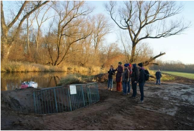
Dr. Maria Vlaic vom NABU Sachsen erläuterte die Arbeiten an der Baustelle. Fotos: René Sievert
