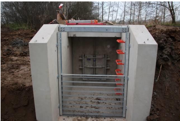
Nahaufnahme des neuen Einlassbauwerks während der Bauarbeiten am Ufer der weißen Elster. Auf dem linken Foto sieht man die Wasserseite, wo das Elsterwasser hineinfließen wird, auf dem rechten die Landseite. Hier wurde später noch ein Rohr angebracht, das unter dem Fahrweg hindurch in ein Absetzbecken führt. Von dort gelangt das Flusswasser dann durch den Wiesen graben in die Lachen. Fotos: Philipp Steuer
